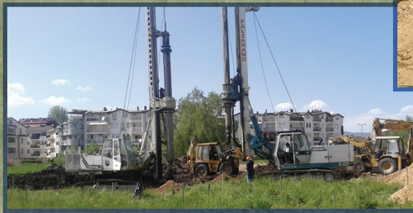
Станбен комплекс Биљанини извори, Охрид
