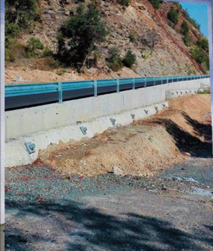
Beton i spërkatur për mbrojtje të pjerrtësive (Hidrojalloviste, nr. 4), xehërore Sasa
