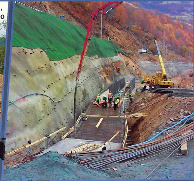
Beton i spërkatur për mbrojtje të pjerrtësive (Hidrojalloviste, nr. 4), xehërore Sasa
