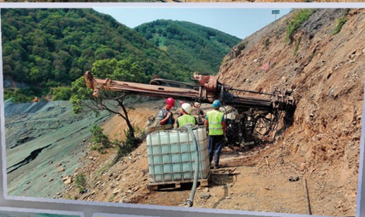
Ankërë vetëtëshpueshëm pasivë, për shnim të pjerrtësisë, Hidrojalloviste, nr. 4, Sasa
